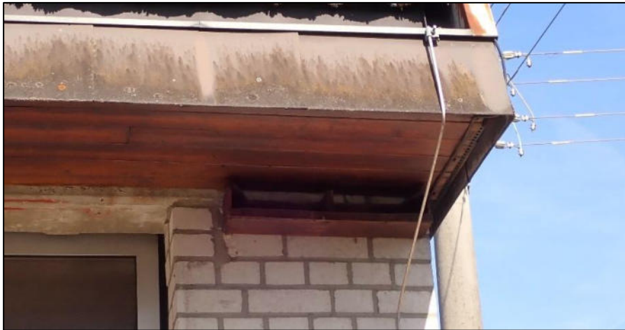
Abbildung 17: Holzkonstruktion am Feuerwehrgebäude.
