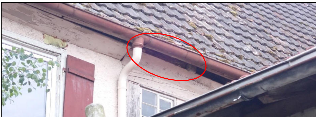
Abbildung 9: Schadstelle am Traufkasten mit zwei Nestern (rote Ellipse).
