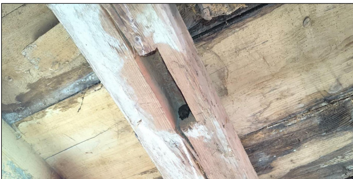
Abbildung 10: Einzelquartier einer Zwergfledermaus in einem Holzbalken.
