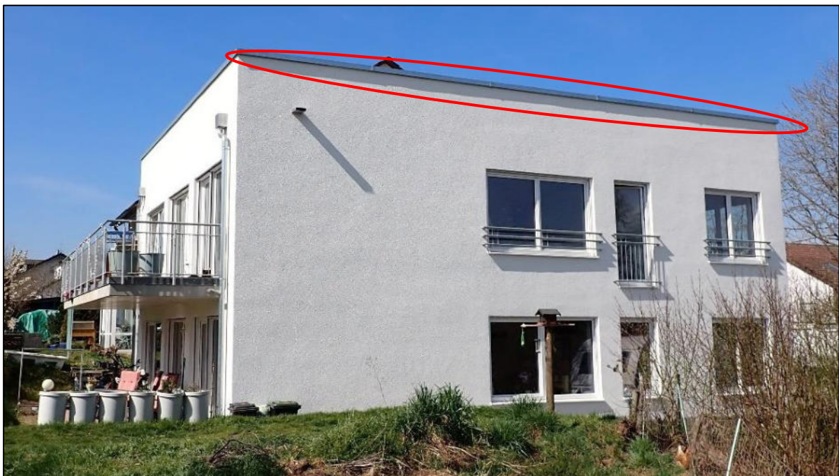
Abbildung 18: Attika (rote Ellipse) am Neubau der Gartenstraße 15.
