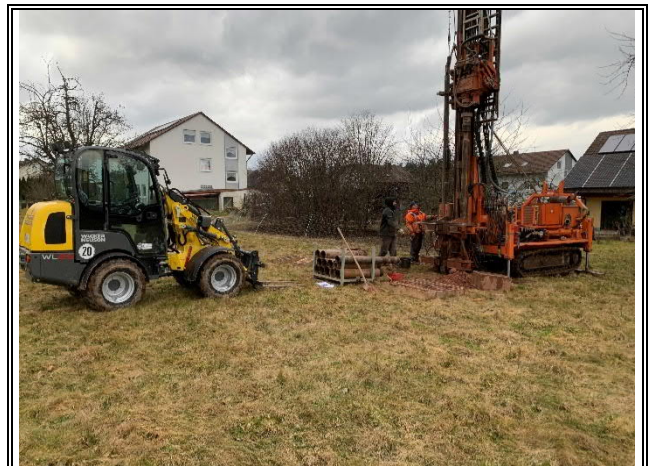
Bohrarbeiten an der Bohrung BK 7
