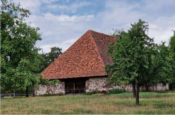
Die Schafscheuer ist ein Kulturdenkmal.
