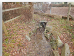
Einlauf Ottebronner Straße
